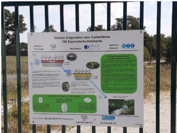
Mise en route de la nouvelle station d'épuration des Corbeillères à Vallet, les filtres roseaux remplaçant les filtres à sable.
