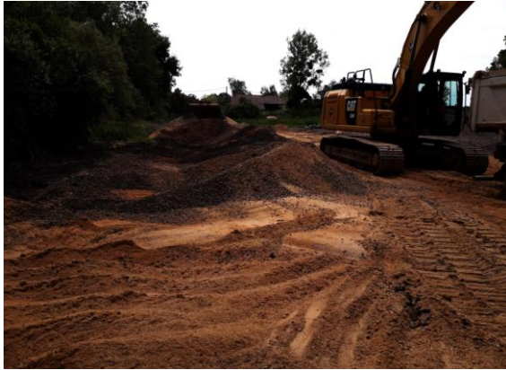
Déconstruction du filtre à sable de la Rouaudière à Mouzillon
