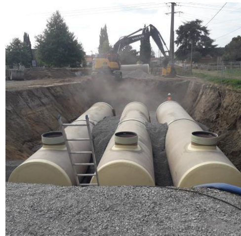
Réalisation du bassin tampon de Saint-Julien-De-Concelles
