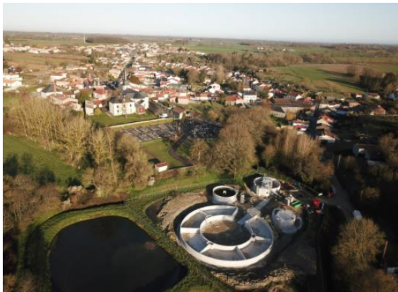
Mise en service de la nouvelle station d'épuration Regrippière
