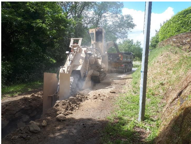
Travaux d'extension du réseau collectif à l'épine à Divatte. Mise en service début janvier 2022
