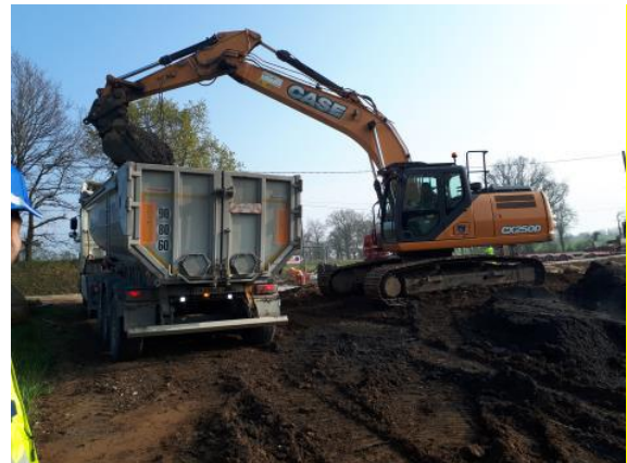
Lancement des travaux de construction de la nouvelle station d'épuration des Corbeillères à Vallet
