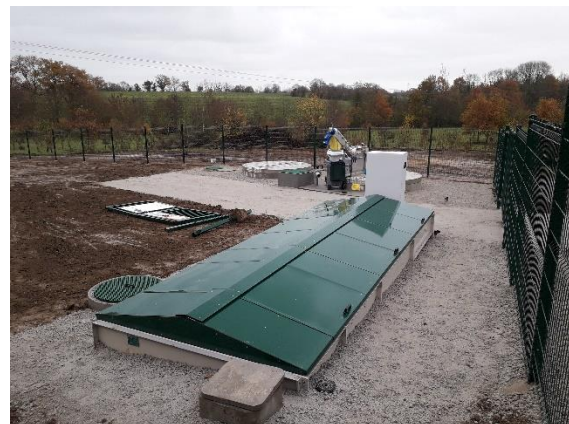
Construction et mise en route de la station d'épuration Débaudière à Vallet
