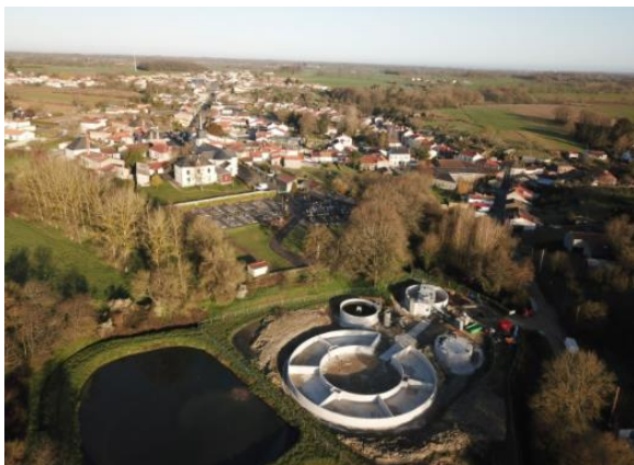
Démarrage construction station d'épuration Regrippière
